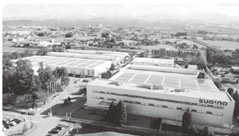
太陽光発電設備 (株式会社スギノマシン滑川事業所さま)
